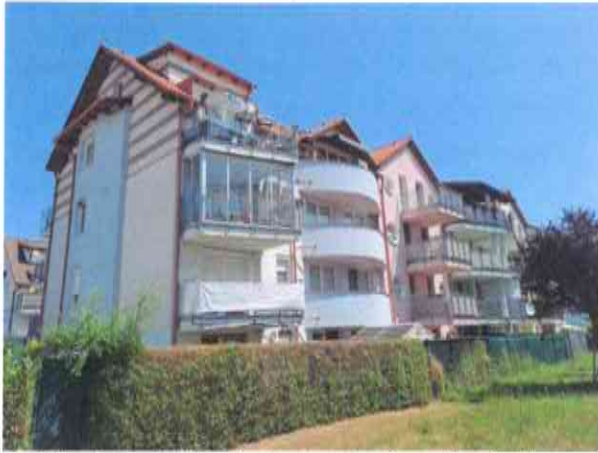
Pohľad na bytový dom zo západnej strany
