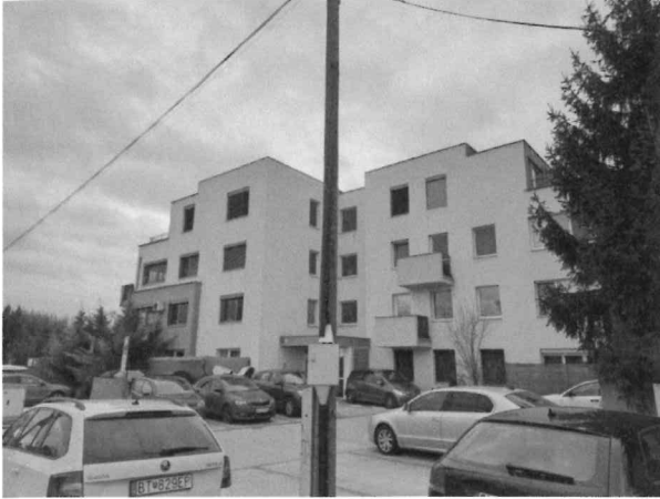
Pohľad na bytový dom z východnej strany
