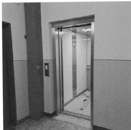
Spoločné priestory bytového domu
