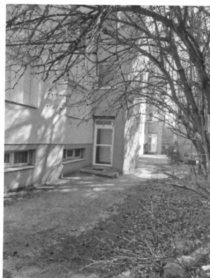
Vedľajší vstup – zo západnej strany
