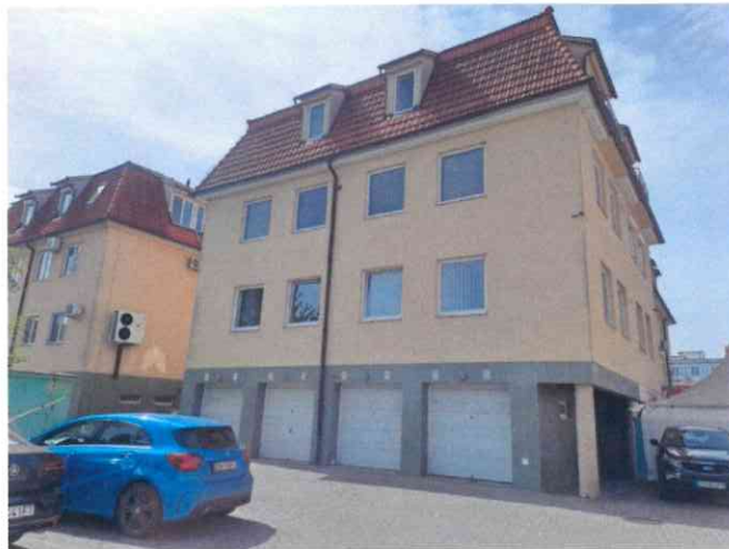
Pohľad z východnej strany
