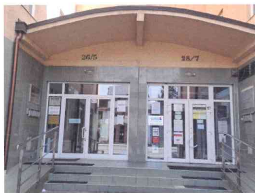
Vstup do objektu
