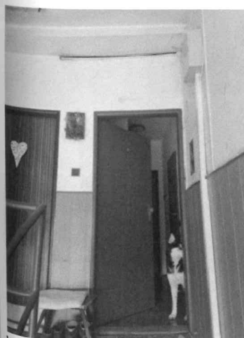
Vstup do bytu
