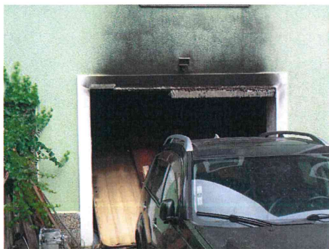
Rodinný dom s.č.2140 – detail obhoretých garážových vrát
