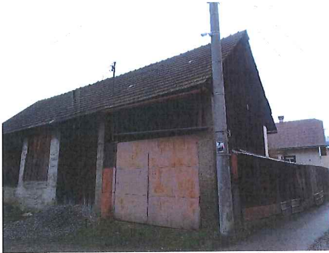
Stodola na p.č.2209 – pohľad juhozápadný
