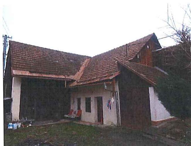
Stodola, dielňa a sklad na p.č.2209 – pohľad juhovýchodný
