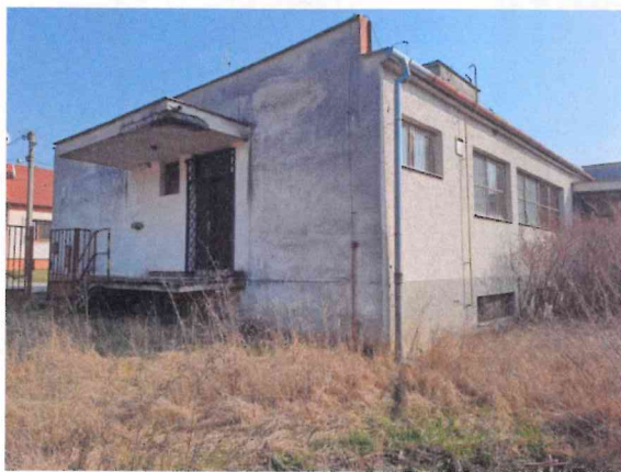
Pohľad na objekt zo S-Z strany
