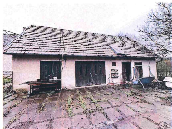
Hospodárska budova súp.č. 69
